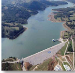
Barajda birikmiş su
